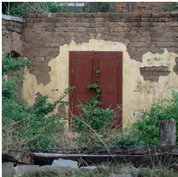
Figura 2 - Fotografia de casa abandonada (São João do Polêsine – RS – Brasil), 2010.
